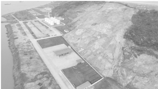
华亿石油 2 号修复前
